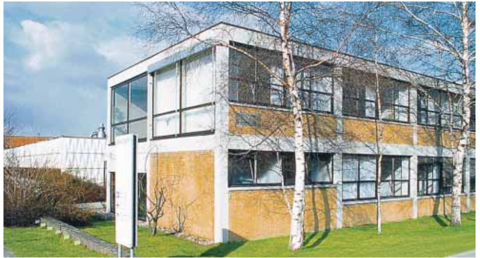
Verwaltungsgebäude, Architekt: Herbert Hirche, 1960
